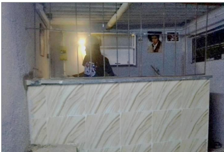
Der Verkehr an der Hauptverkehrsstrasse soll für Einnahmen genutzt werden: Eine Bar wird renoviert und ein Minimarkt entsteht.
